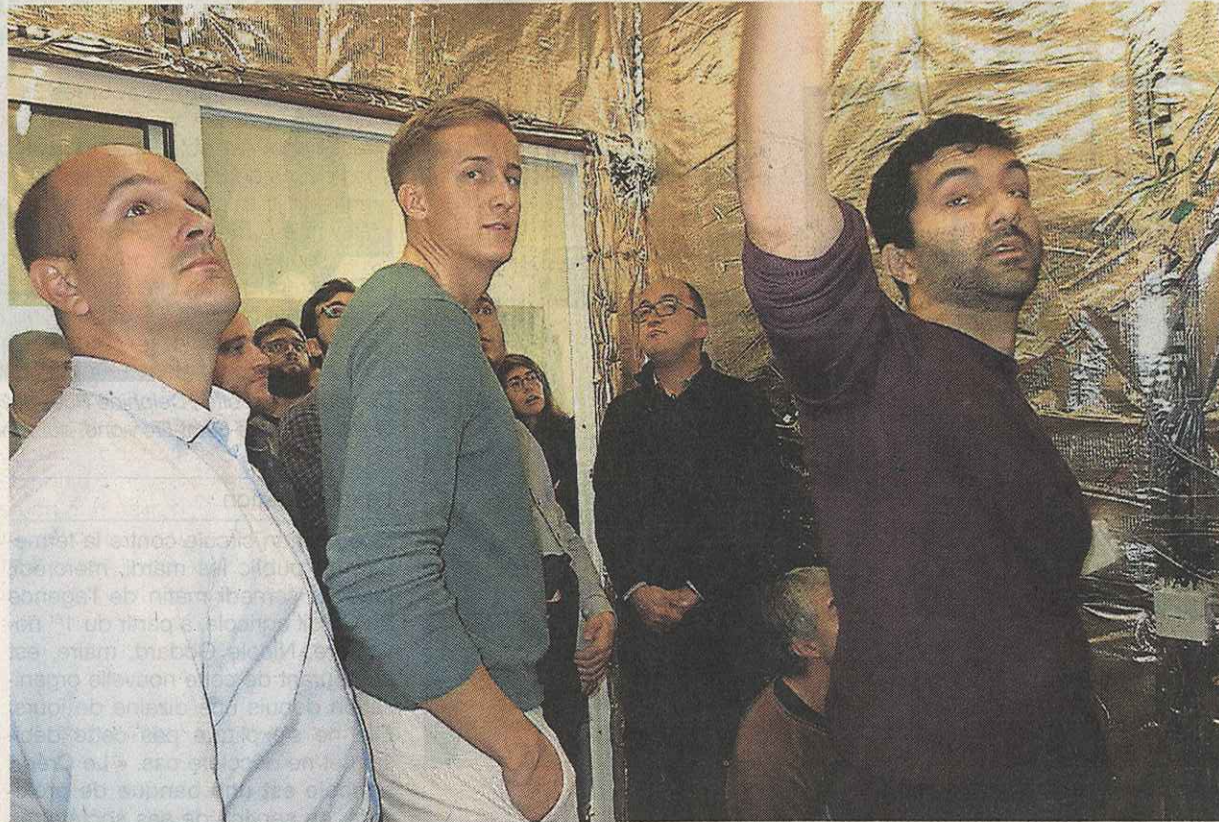
Les chercheurs et ingénieurs européens présents à la réunion ont visité le laboratoire du Lusac, où sont testées de nouvelles techniques de refroidissement des centres télécoms.
